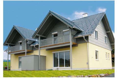
Abb. 4: Gebäudeklasse B, Niedrigenergiehaus Foto: Kohlbacher GmbH
