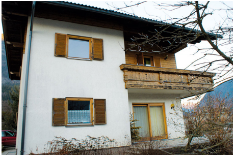
Abb. 2: Gebäudeklasse D, Altbau älter als 20 Jahre, un- oder teilsaniert Foto: AEE Intec
