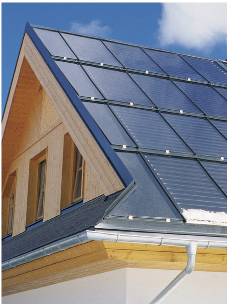
Abb. 7: Eine thermische Solaranlage kann im Sommer den Wärmebedarf decken. Foto: AEE Intec
