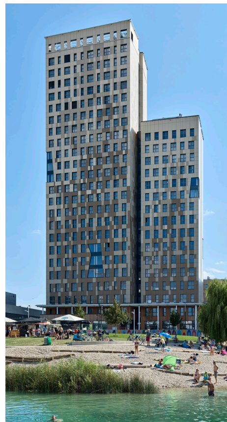
Der Einsatz von 800 Holzstützen aus Fichte anstelle von Stahlträgern im 84 Meter hohen Hoho Wien spart die CO 2 -Emissionen der energieintensiven Stahlproduktion ein.
